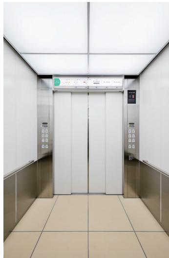
客用エレベーター かご内
