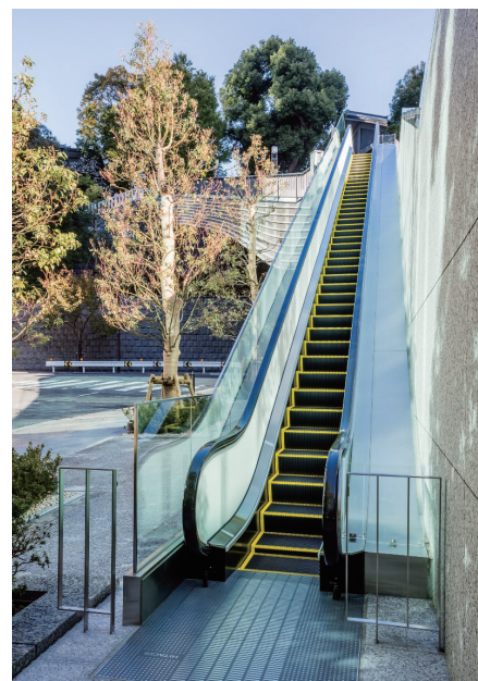
3号機 エスカレーター(勾配30度)
