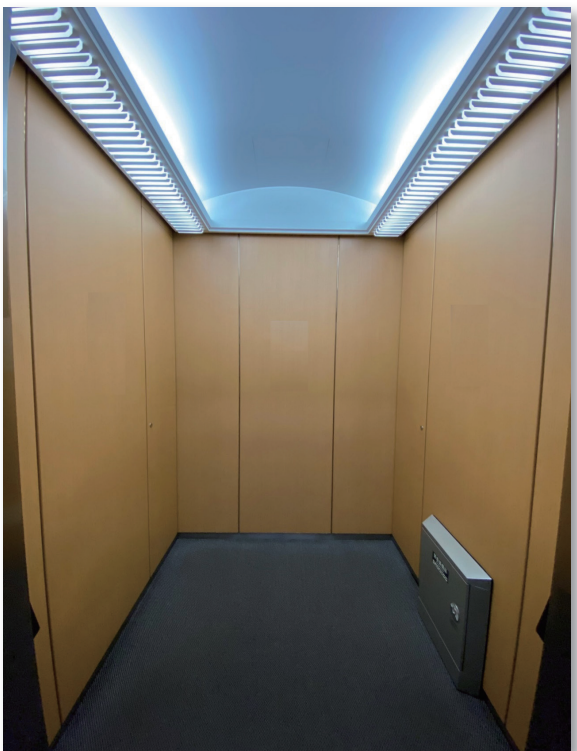
改修前 かが室 (背面側) 間接照明+ドーム天井の既存意匠
