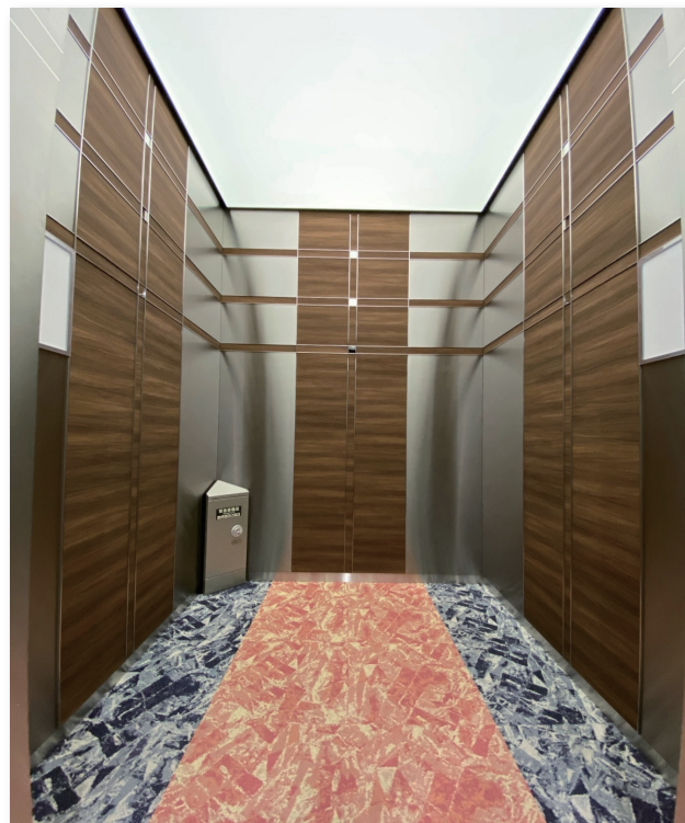
改修後 かが室 (背面側) 全面光膜天井にステンレスと木を基調としたシンプルで上品な意匠
