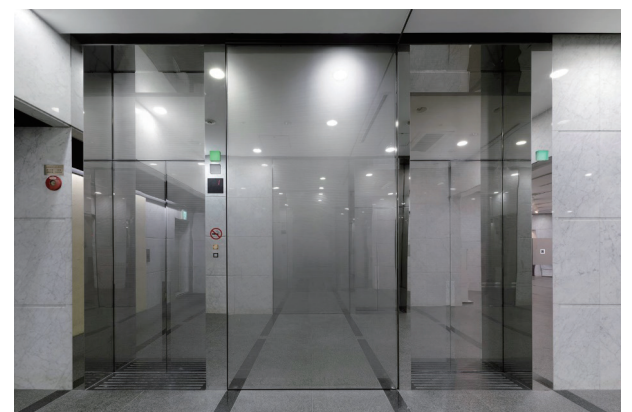
1階乗場戸閉時 (左側号機：リニューアル前) (右側号機：リニューアル後) 【乗場用品既設流用】
