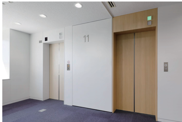
11階乗場 (左側号機：リニューアル前) (右側号機：リニューアル後)
